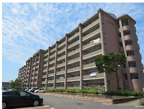
高層耐火7F（ベランダ側）
