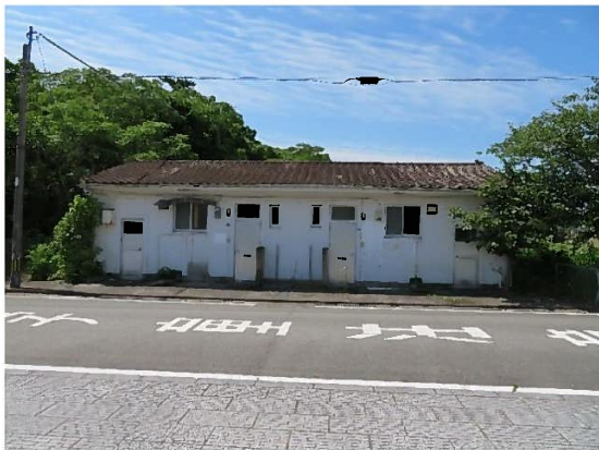
簡易耐火平屋（玄関側）
