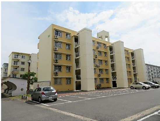
中層耐火5F (EV設置済み)
