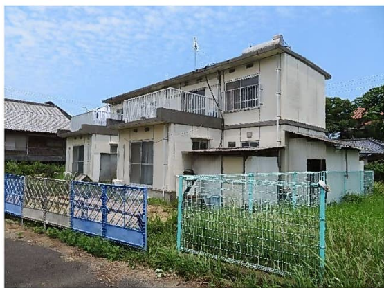
簡易耐火2F（ベランダ側）
