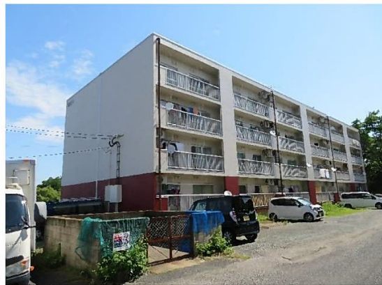
中層耐火4F（ベランダ側）
