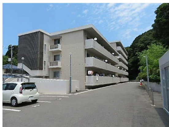
中層耐火3F、5F（ベランダ側）
