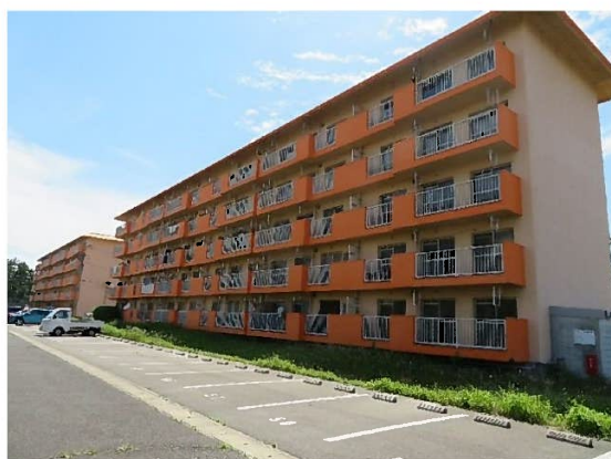
中層耐火5F (ベランダ側)
