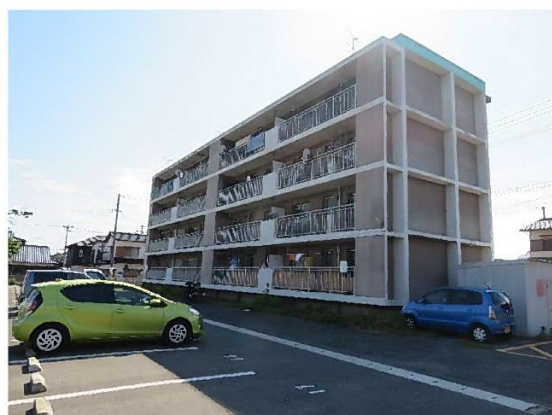
中層耐火4F（ベランダ側）
