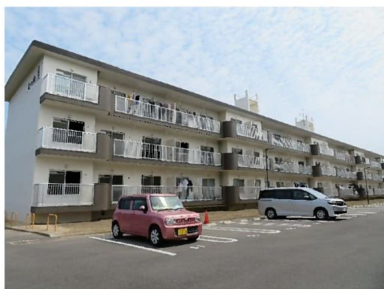
中層耐火3F（ベランダ側）
