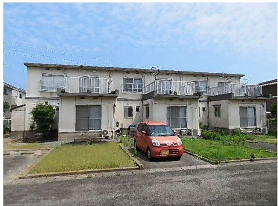
簡易耐火2F（ベランダ側）
