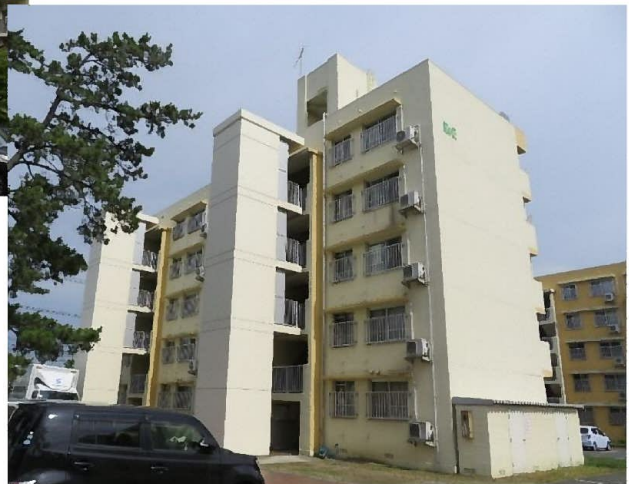
【EV 設置後住棟】
