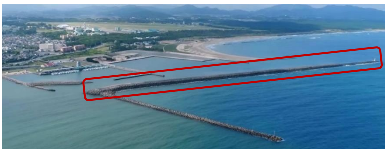
芦屋港 北防波堤（沖から撮影）
