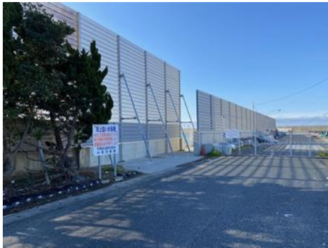
東防波堤侵入口（防砂フェンスの奥は、漁協への飛砂対策で設置された部分
