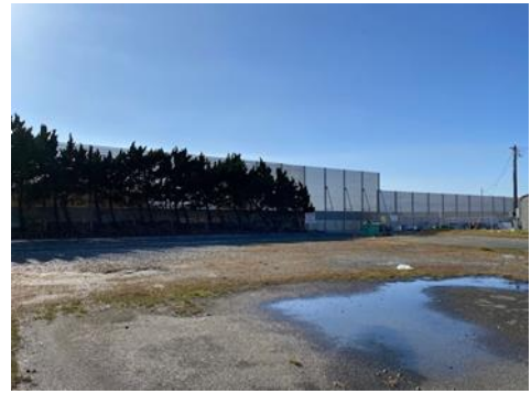
駐車場予定地より 3 号野積場を望む （防砂フェンス）
