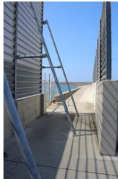
東防波堤侵入箇所
