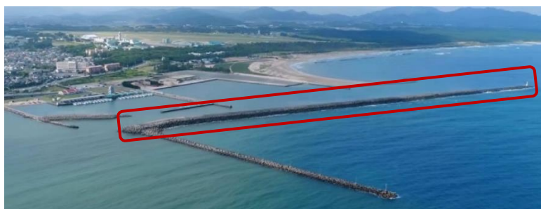
芦屋港 北防波堤（沖から撮影）
