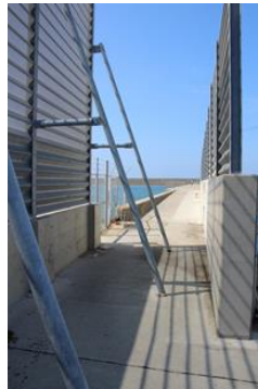
東防波堤侵入箇所
