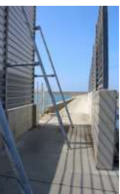
東防波堤侵入箇所
