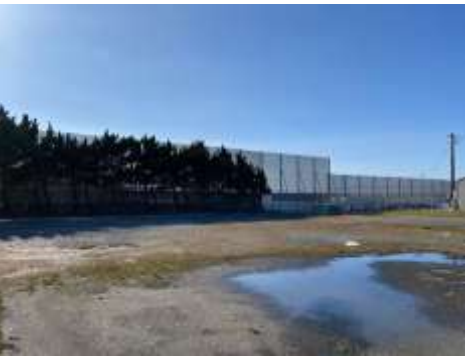
駐車場予定地より3号野積場を望む(防砂フェンス)
