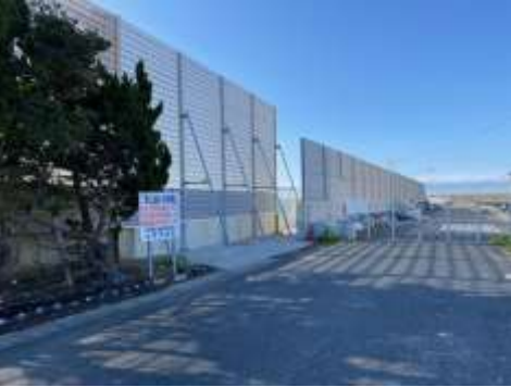
東防波堤侵入入口(防砂フェンスの奥は漁協への飛砂対策で設置された部分)
