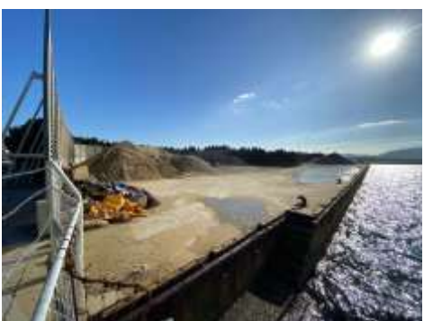
3号野積場の東防波堤との接続部 印の岸壁部より浮棧橋が設置される見込み
