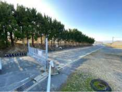
1号野積場(駐車場動線部)より3号野積場防砂フェンス
