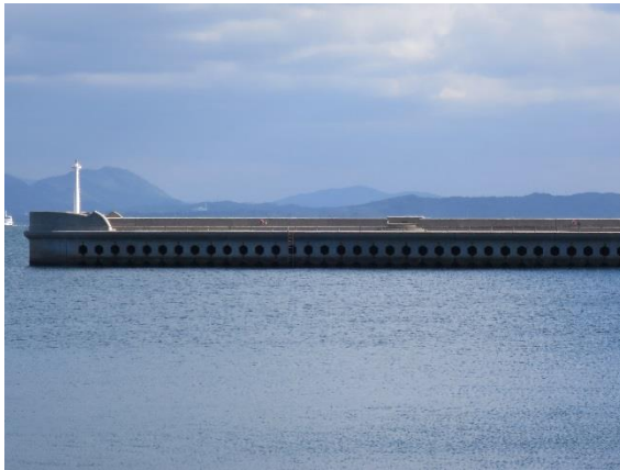
〔参考〕 うみんぐ大島の波除堤 波を受け止め内側にゆっくり流れる構造
