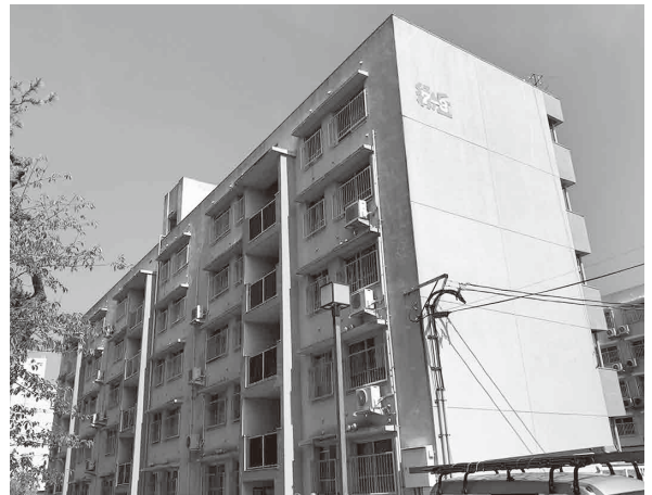
外部改修工事を行う3棟
