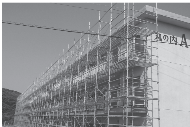
改修工事中の丸の内団地A棟
