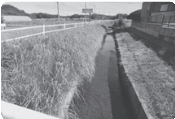
約600mのコンクリート張りが計画されているのり面
