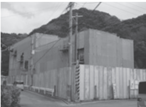
建設工事途中の新後水団地 (H30.1撮影)
