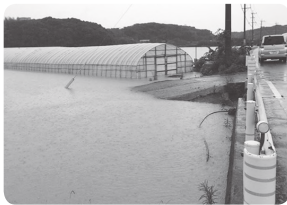
大雨で冠水した山鹿裏耕地 (H29.7.7 撮影)
