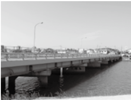
架け替えられる西祇園橋
