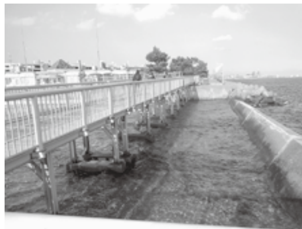
外周にフェンスが設置された横浜市大黒海釣り施設
