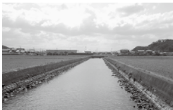
改修工事が行われる汐入川
