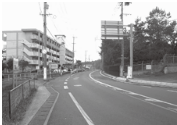
県から移管された国道495号線
