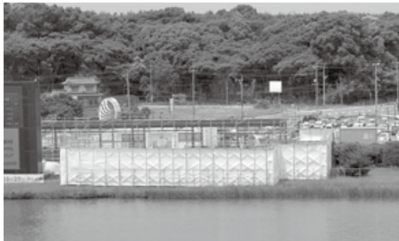
増築工事中の芦屋競艇場外向け発売所（アシ夢テラス）
