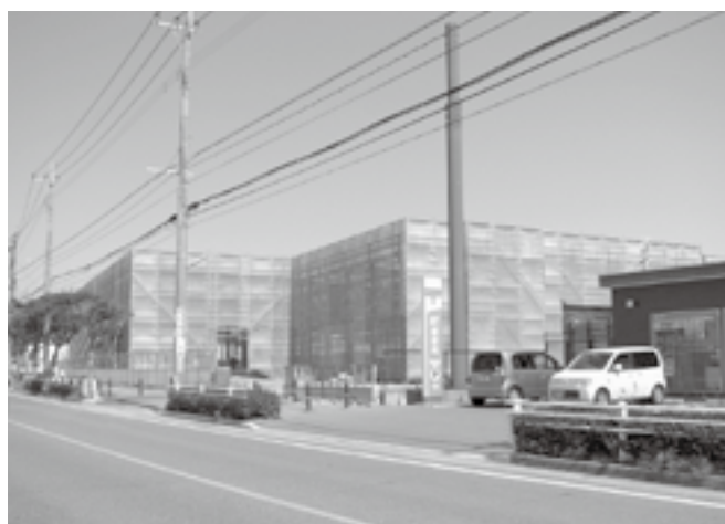
山鹿に建設中の商業施設
