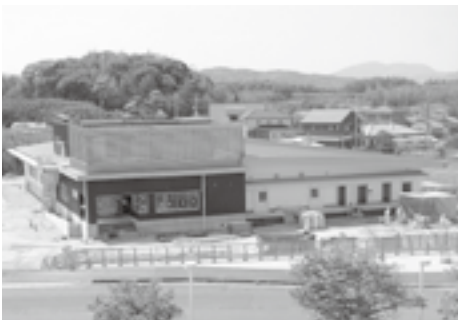
芦屋競艇場敷地内に建設中の新給食センター
