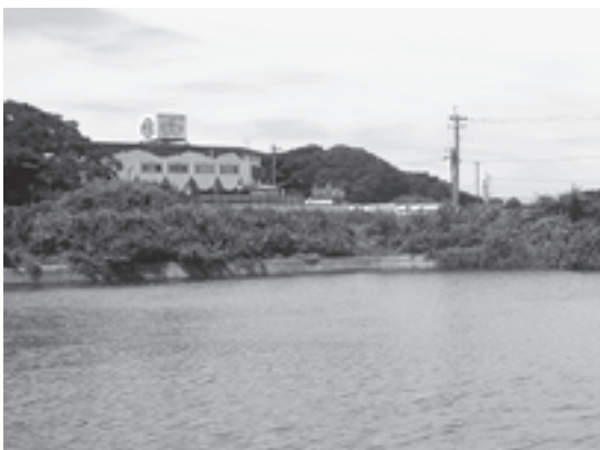
侵食防止工事が行われる山鹿狩尾池(農業用ため池)
