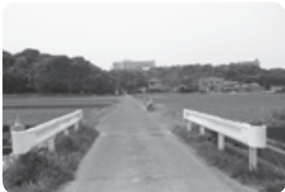
汐入川にかかる築廻4号橋
