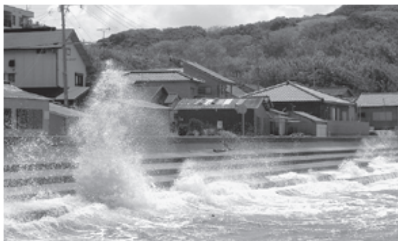
越波により侵食を受ける柏原西方海岸（H26・4・4撮影）
