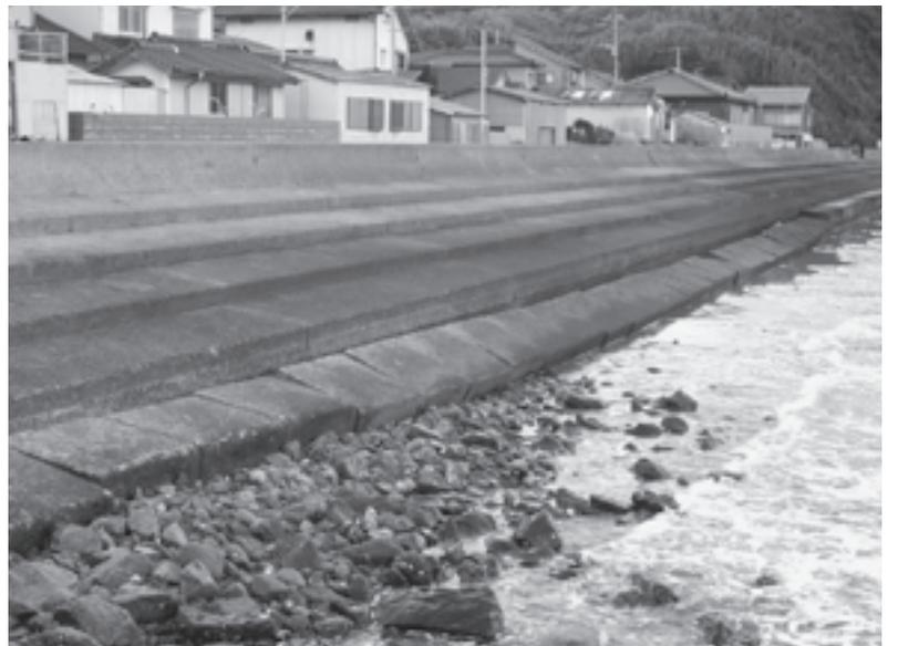
波に侵食され、護岸が崩落している柏原西方海岸（H 25.10.21）
