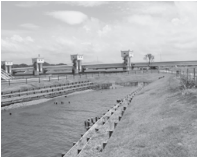
遠賀川河口堰に整備された遠賀川魚道公園
