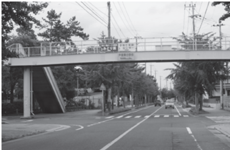
補強工事が予定されている緑ヶ丘歩道橋
