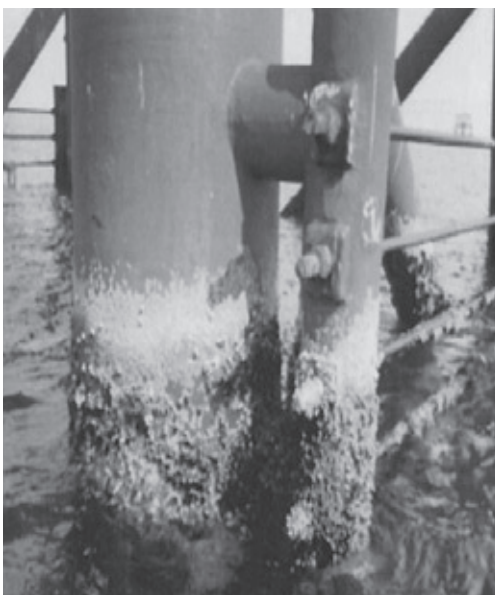
シーバースの配管橋を支える鉄鋼構造物
