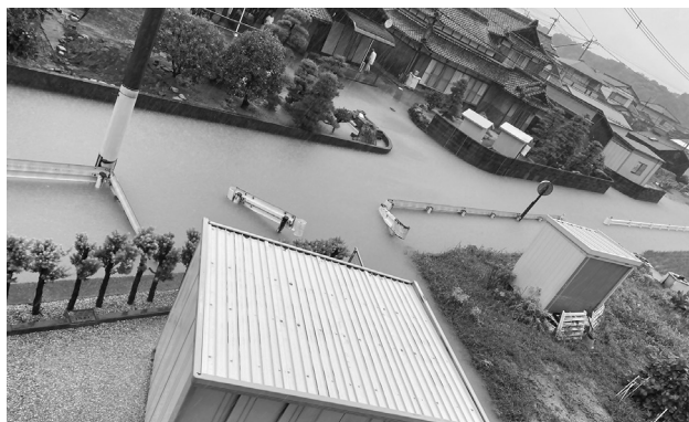
床下浸水寸前の家屋（近隣住民より提供）
