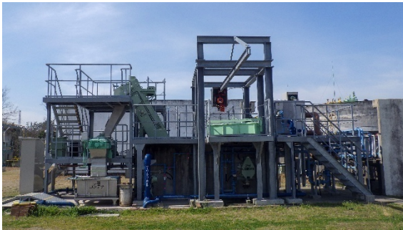
下水道処理施設
