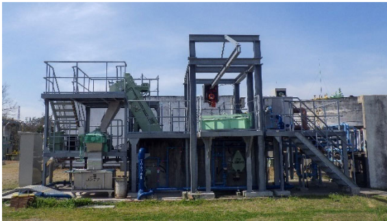
下水道処理施設
