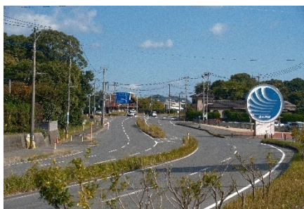
国道 495 号（ポートルース芦屋付近）
