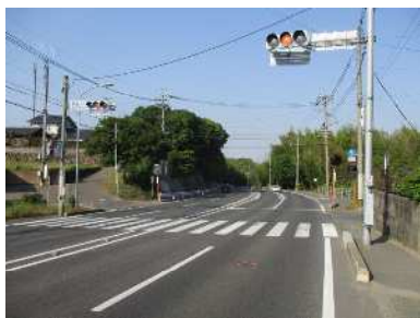
国道 495 号（芦屋大城付近）
