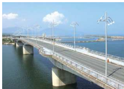
なみかけ大橋
