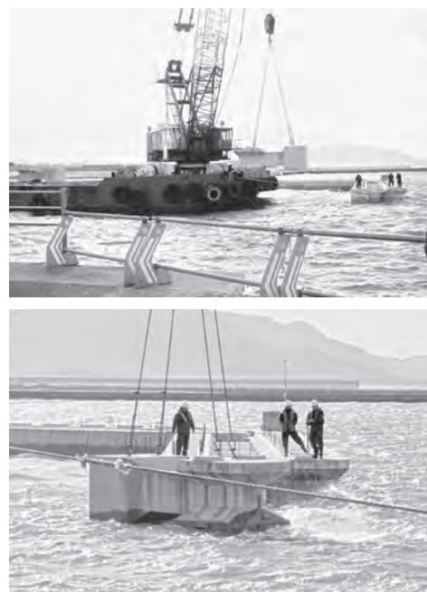
▽魚釣施設築造工事の様子
