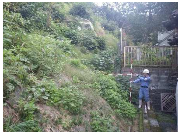
基礎調査の様子
