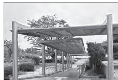
総合体育館スロープ屋根等設置
