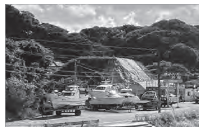
町有地法面崩落対策工事
