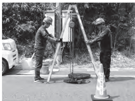
◀マンホールポンプでの現地作業の様子
