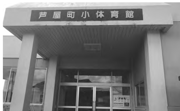
空調設備がされていない小体育館
