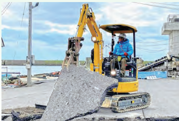
△蛸島漁港の仮復旧作業
