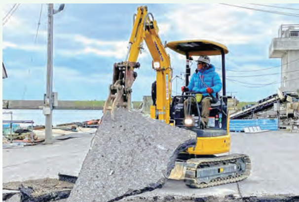
△蛸島漁港の仮復旧作業
