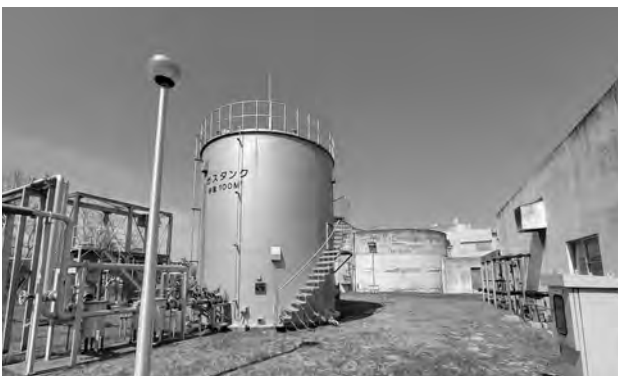
一部耐震化された芦屋町浄化センター
