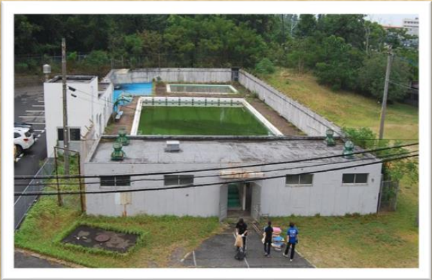
旧プール全景
