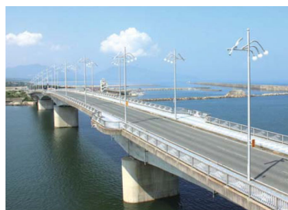
なみかけ大橋
