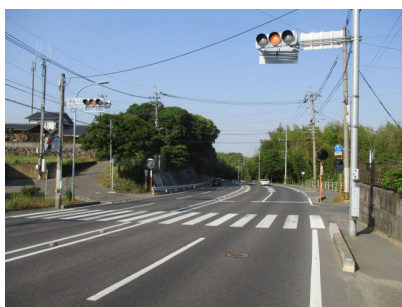
国道 495 号（芦屋大城付近）
