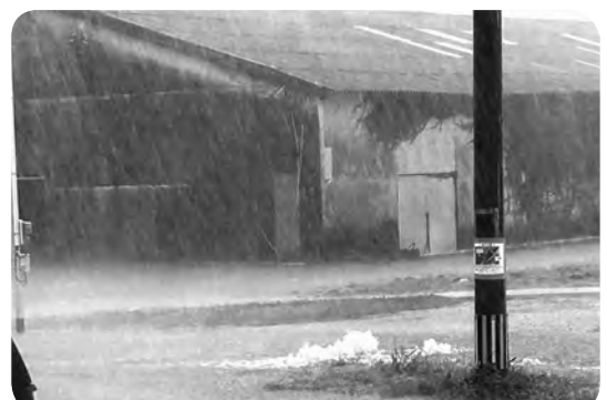
雨により冠水している漁具倉庫
