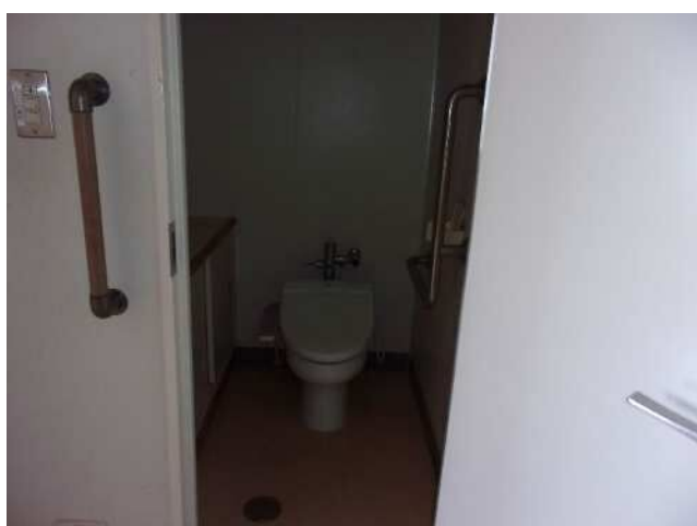
2F 病棟トイレ
