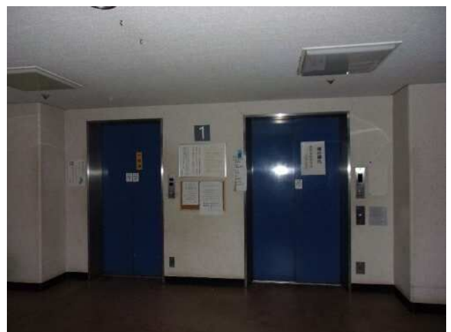
1F エレベーター
