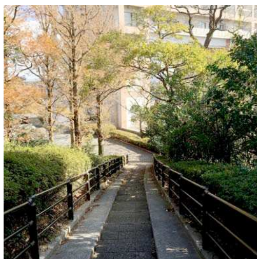
第1展望所～マリンテラス間の階段とスロープ/幅員約2m
