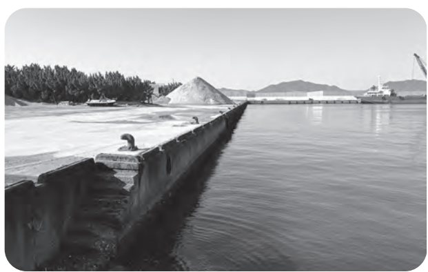
整備が進む芦屋港
