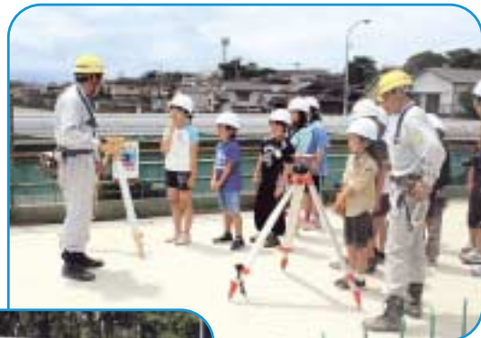
● 芦屋橋工事学習会
