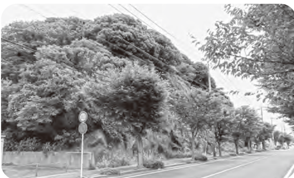
避難ルートの整備が望まれている城山公園
