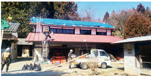
△家屋屋根復旧作業の様子（福島県新地町） 写真提供：NPO 法人災害救援レスキューアシスト
