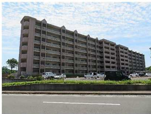
高層耐火7F（玄関側）
