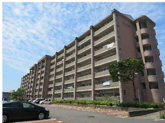
高層耐火7F（ベランダ側）
