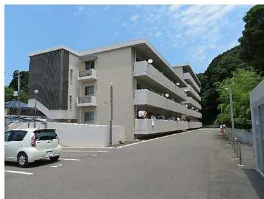
中層耐火3F、5F (ベランダ側)
