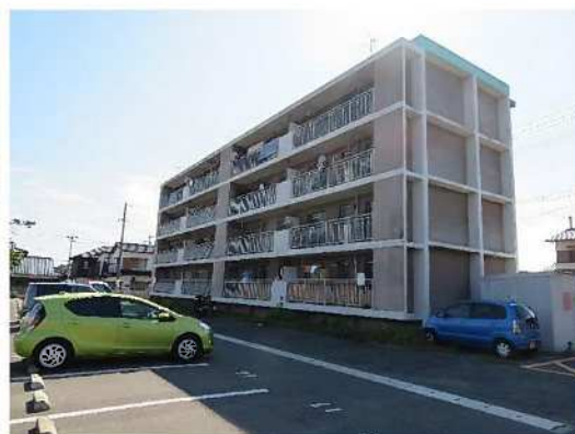
中層耐火4F（ベランダ側）
