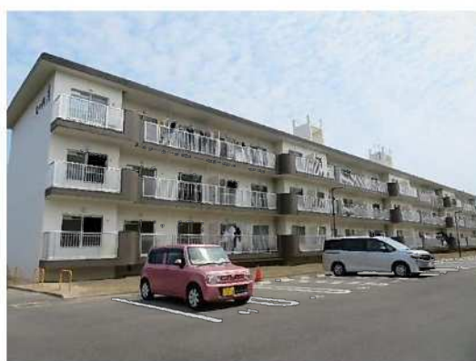
中層耐火3F (ベランダ側)
