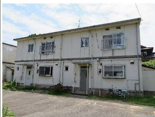
簡易耐火2F（玄関側）
