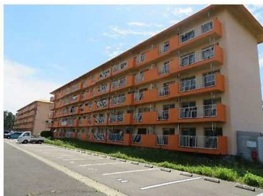
中層耐火5F (ベランダ側)
