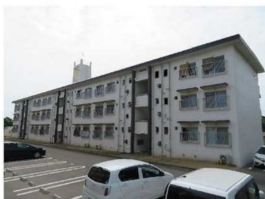
中層耐火3F (玄関側)
