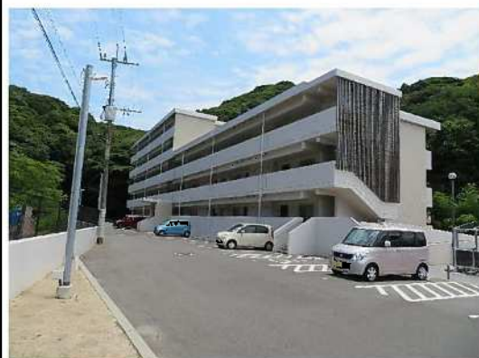
中層耐火3F、5F (玄関側)
