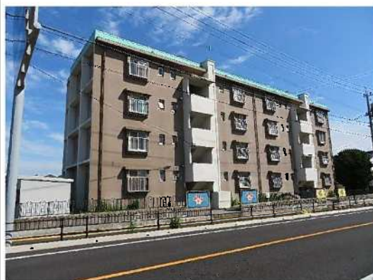
中層耐火4F（玄関側）
