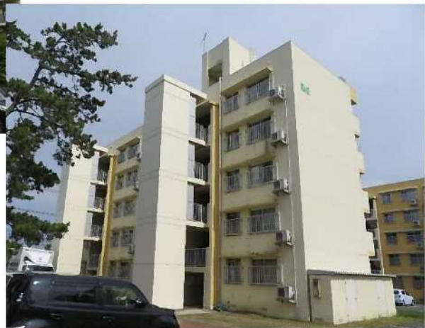
【EV 設置後住棟】
