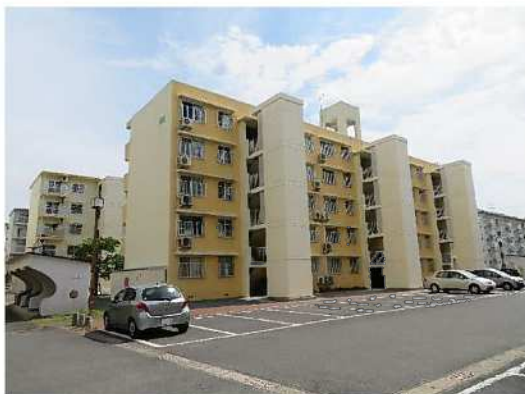
中層耐火5F (EV設置済み)
