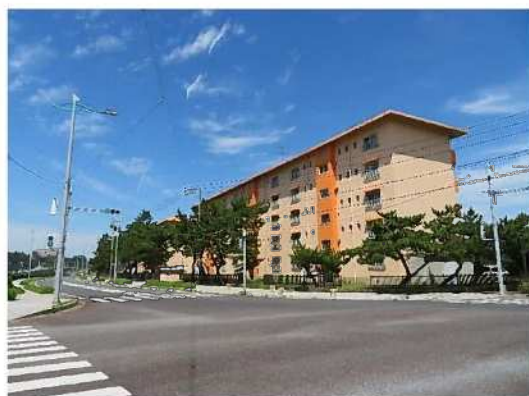
中層耐火5F (玄関側)
