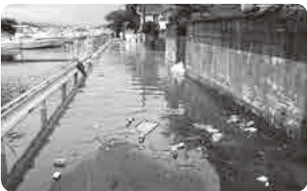
平成22年7月14日の豪雨災害の様子（三軒屋地区）
