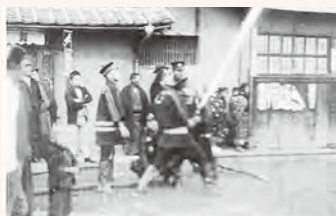
△消防団による放水実施試験
