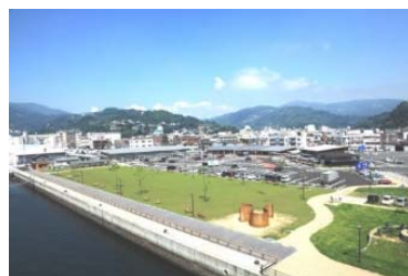
八幡浜みなと外観
