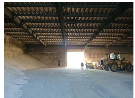
1号上屋の内部
