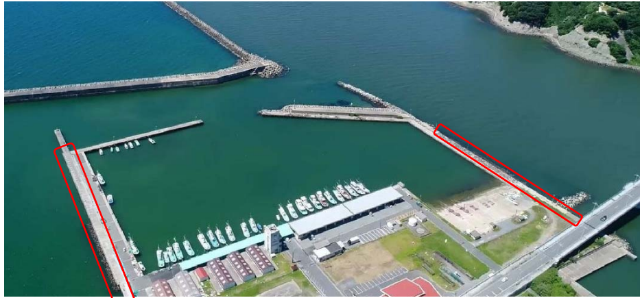
東防波堤（野積場より撮影）
